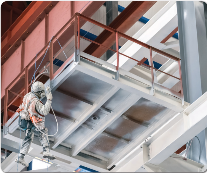
Thi công sơn
